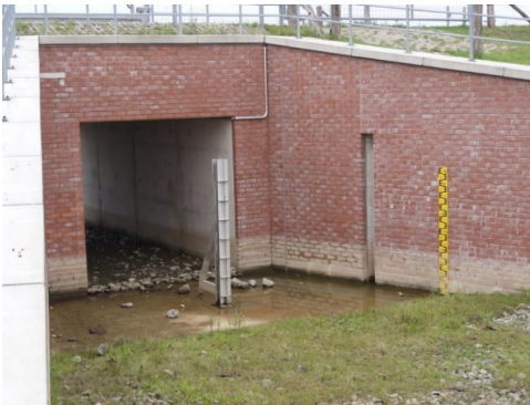
fig 2 Het inlaatwerk met een opening van ongeveer 3x3m
